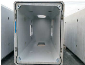
图7.2 预制管廊节段及防水构造示意图
