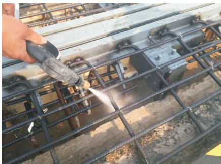
图6.7 伸缩缝预留槽清理
