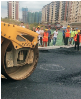
图1.6 检查井盖与沥青混合料同步碾压
