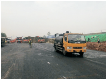
图2.6 下层清扫后洒布粘油
