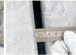
图7.4 管廊节段间缝宽检查
