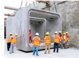
图7.3 预制综合管廊安装
