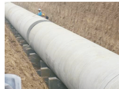
图4.4 平口管安装示意图
