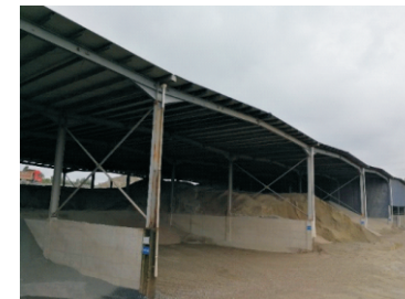
图2.5 集料仓分仓隔离设置并设置防雨顶棚
