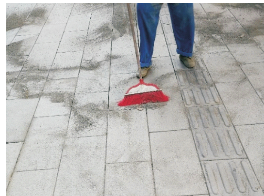
图3.6 细砂扫缝
