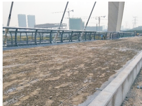
图3.5 干拌水泥砂灌缝
