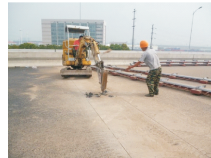
图6.4 伸缩缝预留槽切边及破除沥青砼
