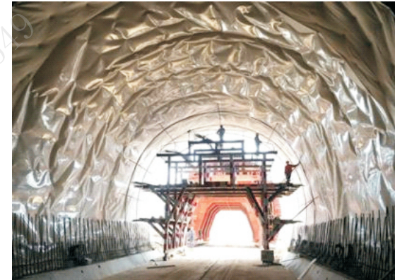
图8.9 矿山法隧道防水层施工
