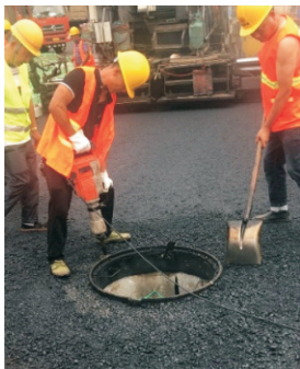
图1.4 限位井筒周围沥青混合料夯实
