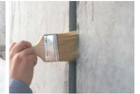
图7.5 管廊节段拼缝清扫
