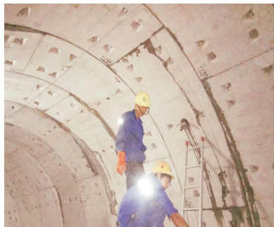
图8.2 盾构隧道渗漏堵漏处理
