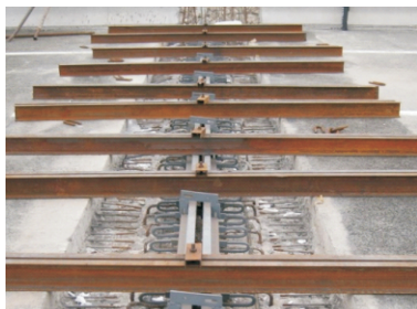
图6.5 型钢伸缩缝精调平
