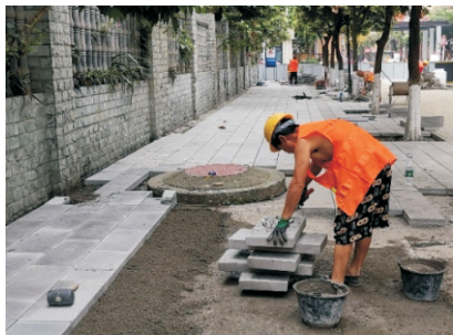
图3.4 铺装挂线施工
