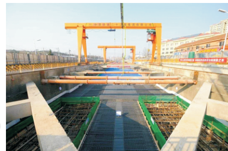
图8.3 地下明挖结构
