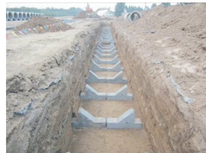
图4.3 预制枕梁安装示意图
