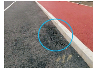
图5.2 雨水篦安装应比路面略低
