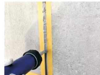
图7.6 管廊节段拼缝涂胶
