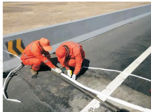
图6.8 型钢伸缩缝止水带及胶泥施工图
