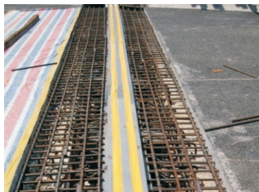
图6.6 伸缩缝锚固筋施工及防堵塞示意图
