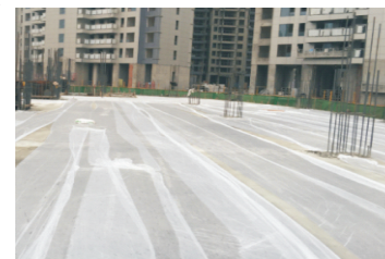
图2.14 现浇板面覆膜养护
