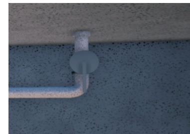
图1.8 地漏阀门设置
