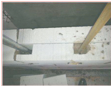
图3.4 管线预埋凹槽砌块
