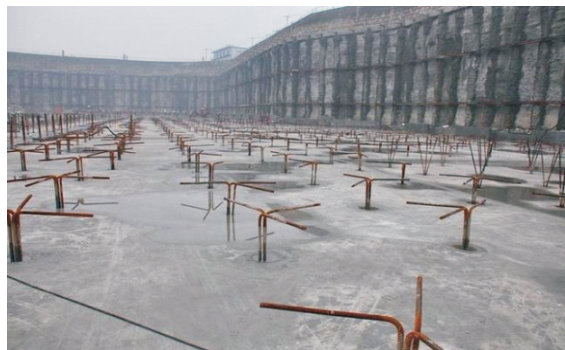
图1.2 抗浮锚杆施工
