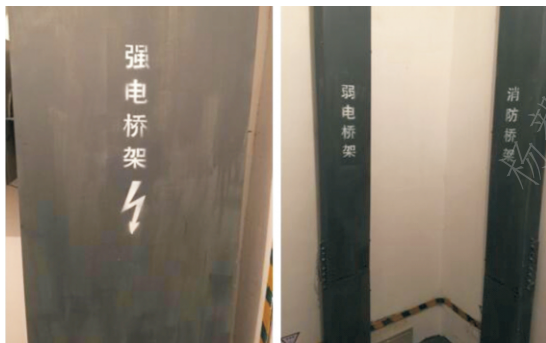
图6.2 强弱电独立设置桥架
