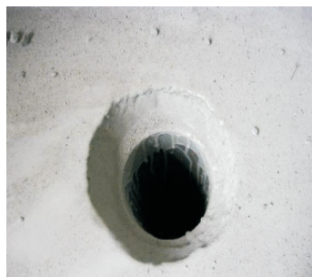
图5.12 地漏环形凹槽
