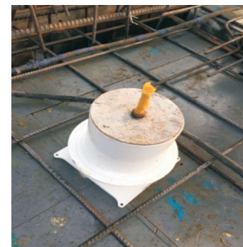
图5.16 止水节安装
