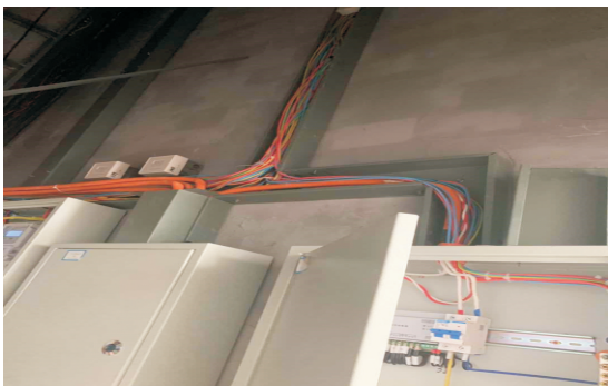
图6.1 桥架容积率超标
