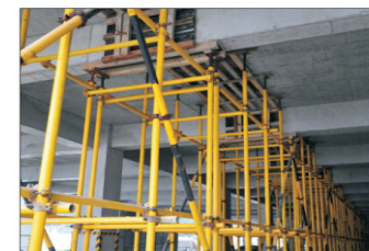
图1.5 后浇带模板支撑图
