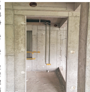
图9.4 户内给水管道暗埋样板
