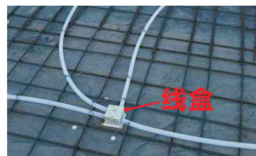
图2.4 现浇板线管交叉处采用线盒转接
