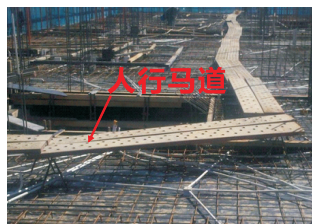
图2.9 作业层铺设人行马道
