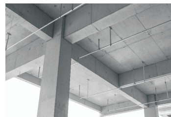
图2.17 现浇板板底成型效果好
