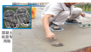
图2.13 现浇板人工二次收面
