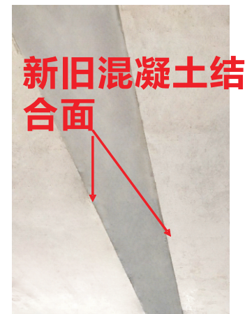
图2.24 装配式叠合板拼接缝成型效果好
