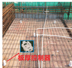
图2.10 楼板厚度控制器控制板厚
