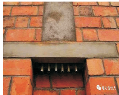
图3.3 预留洞设置孔槽过梁
