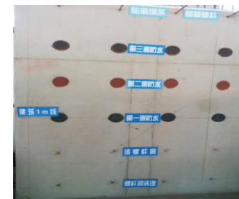
图4.11 外墙拉杆洞封堵施工样板
