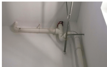
图8.2 排水支管连接点不满足8.1.1要求
