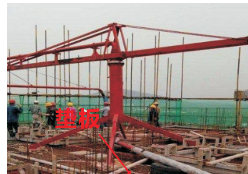
图2.23 布料机底增设垫板
