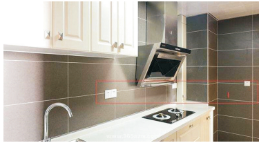
图7.2 厨房未采用防溅水型电源插座
