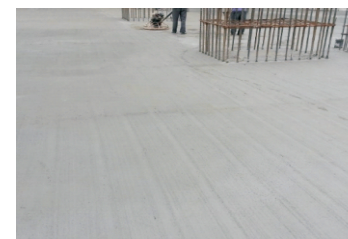
图2.18 现浇板板面成型效果好
