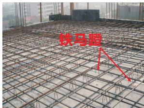
图2.8 现浇板设置铁马凳
