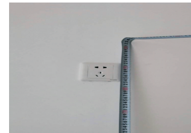
图7.5 幼儿园插座安装高度1.8米以上
