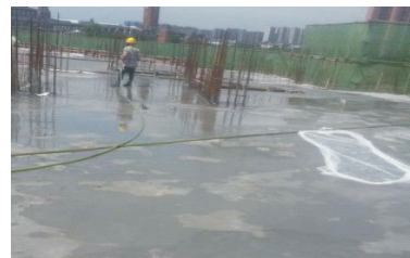
图2.15 现浇板面洒水养
