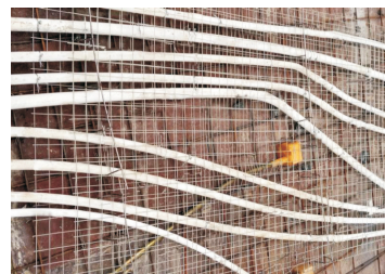
图2.6 现浇板管线上方附加钢筋(丝)网
