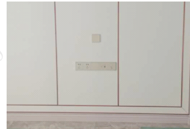
图7.3 插座安装平整
