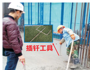
图2.11 采用插钎工具检查板厚
