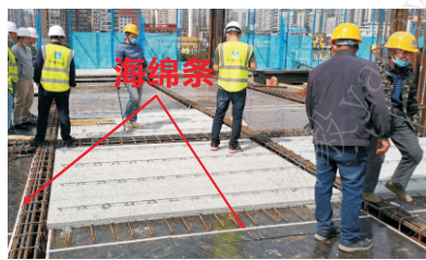
图2.22 梁板交接及拼接缝处粘贴海绵条
