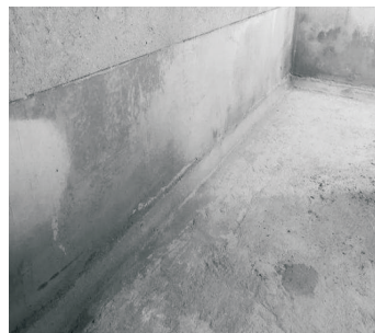
图5.13 基层角部圆弧形
