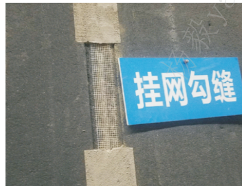
图3.6 隔墙板挂网勾缝
