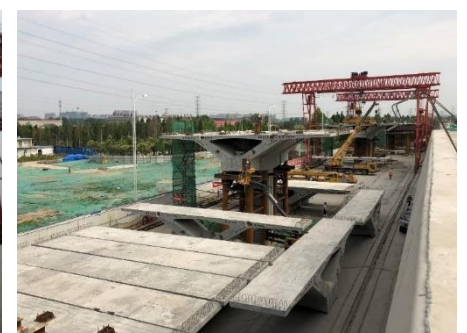
节段标准化预制示意
