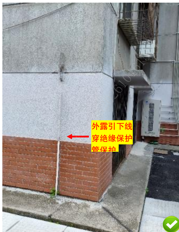
图 6.11.2 外露引下线穿绝缘保护管保护
