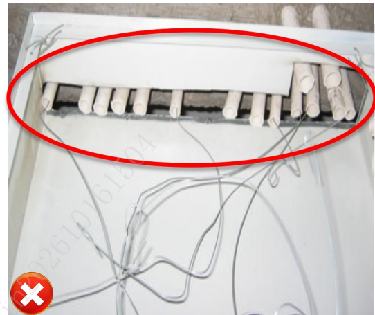
图 7.1.1-1 电线凌乱，线管脱落 图 7.1.1-2 箱体安装歪斜，无预制管口
