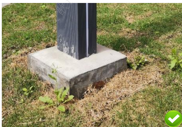
图 6.10.2 螺栓采用混凝土保护
