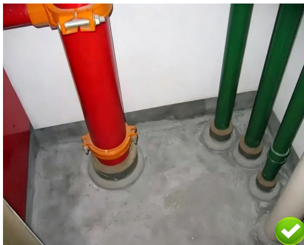
图 4.3.2 管道穿楼板防水套管施工规范
