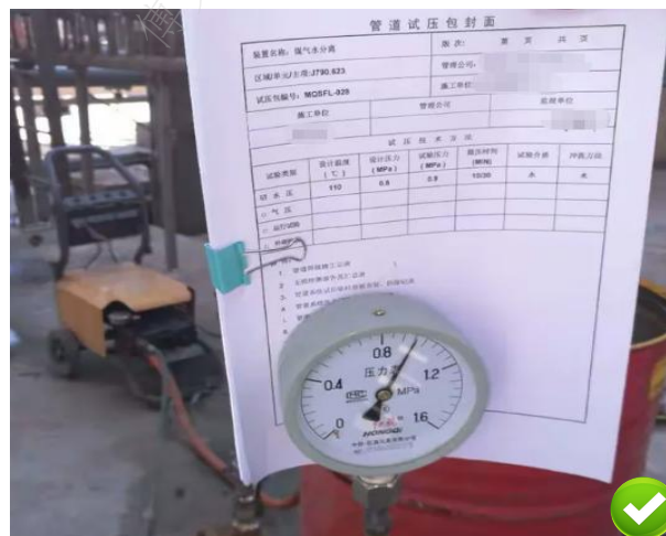
图 5.6.2-3 水压试验记录与影像一致真实有效
