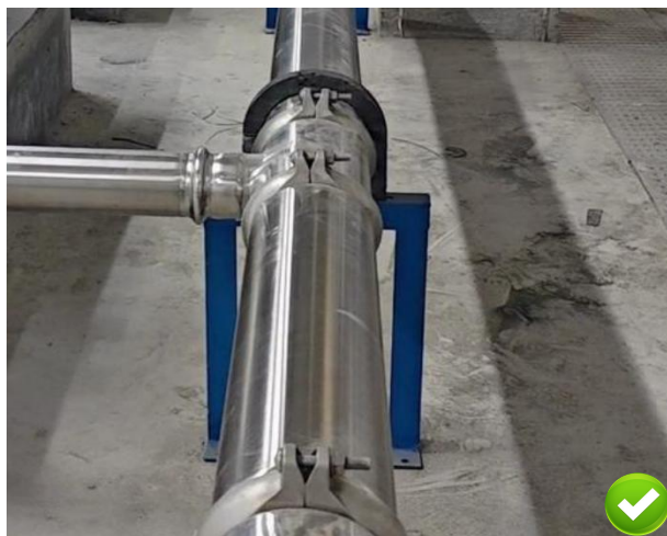
图 5.1.2-2 卡箍式连接，卡紧螺栓后管道平直，卡箍安装方向一致
