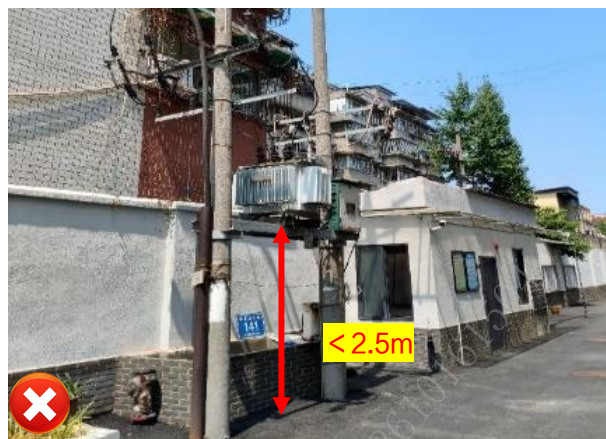
图 6.1.1-1 柱上变压器台底部距地面高度 < 2.5\text{m}
