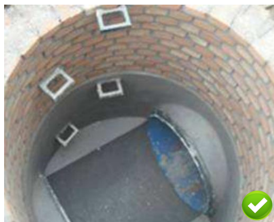
图 5.5.2-1 管道与雨水井壁处填塞严密、
