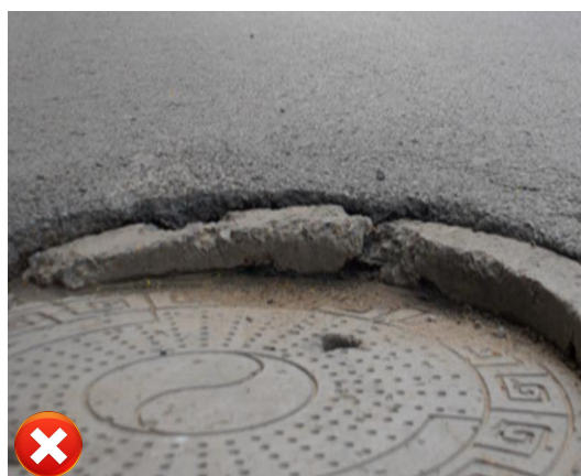
图 5.5.1-4 井盖高低差超标、异响松动
