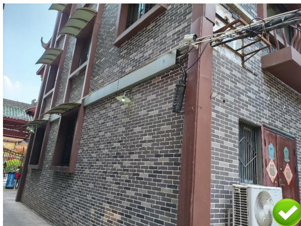
图 6.3.2 外墙面线缆用桥架保护
