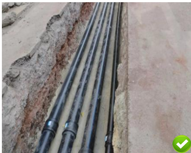
图 5.4.2-1 管沟底部平整，填铺细砂
