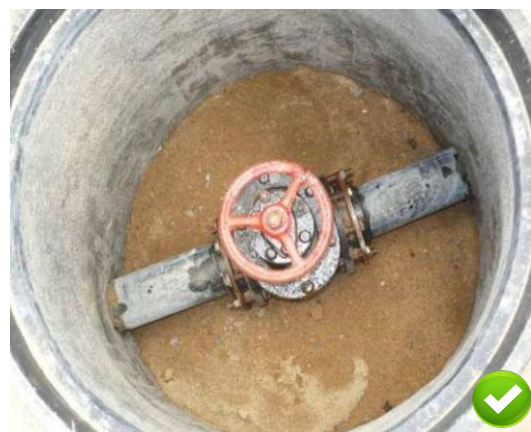
图 5.5.2-2 井壁距法兰的距离符合规范要求
