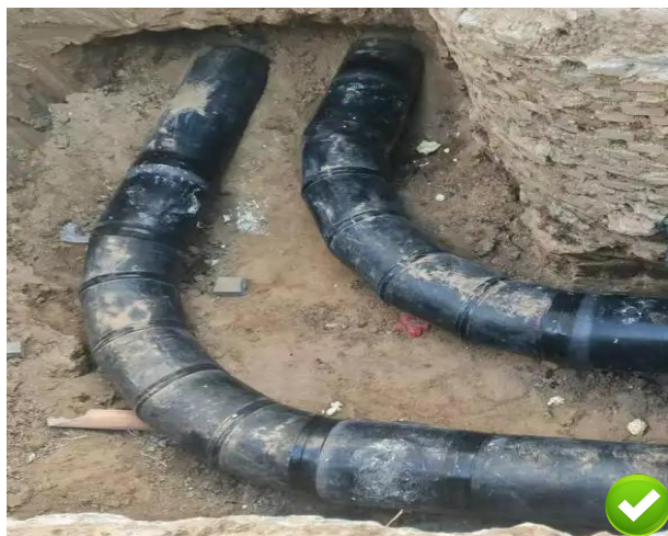
图 4.4.2 底漆涂刷完整
