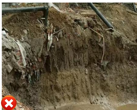
图 5.4.1-1 沟槽开挖坡度不足、存在塌方隐患 图 5.4.1-2 管沟垫层缺失，有尖硬杂物
