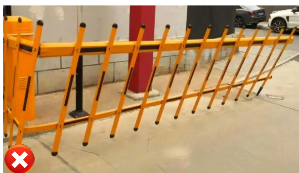
图 7.3.1-1 栅栏间隙过大
