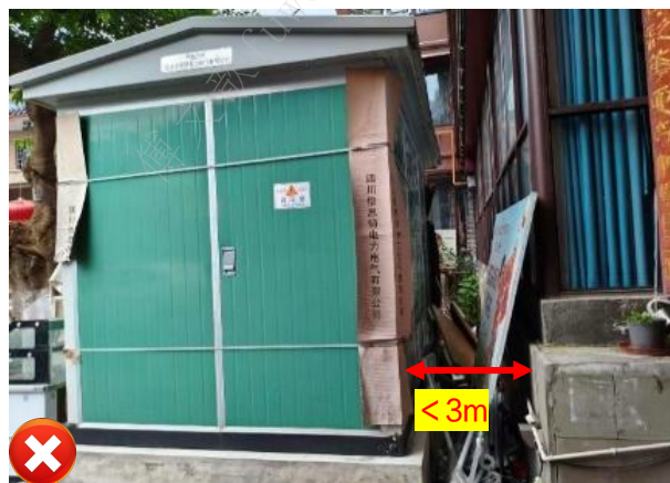
图 6.1.1-2 箱变与民用建筑的防火间距 < 3\text{m}
