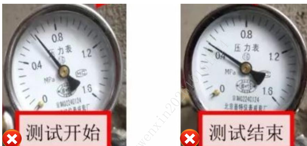
图 5.6.1-1 压力试验测试压力下降
