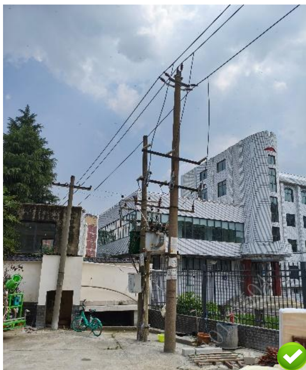
图 6.1.2 柱上变压器台底部距地面高度 \geq 2.5\text{m}
