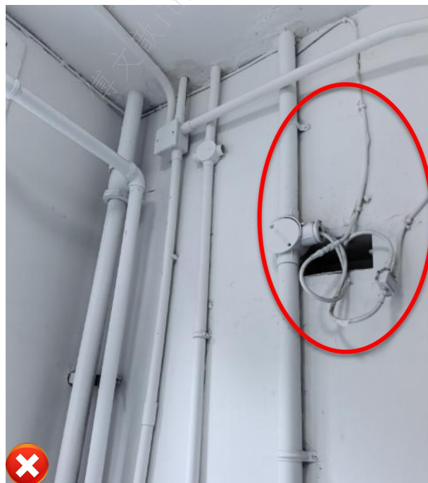
图 7.1.1-1 电线凌乱，线管脱落 图 7.1.1-2 箱体安装歪斜，无预制管口
