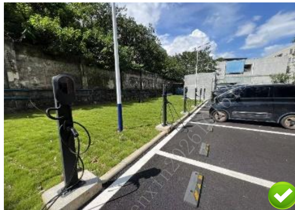
图 6.7.2 落地式充电设备基础
