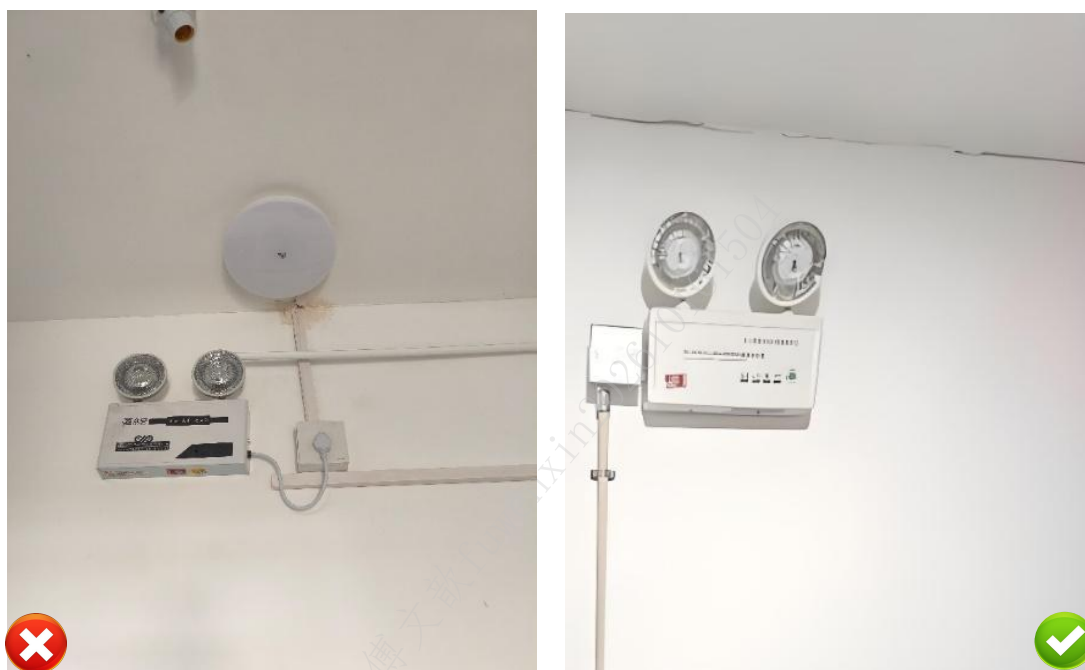
图 6.8.1 应急照明线路明敷采用塑料槽盒 图 6.8.2 应急照明线路明敷采用金属导管
