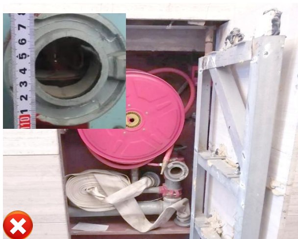
图 5.3.1-1 栓口中心距地不满足 1.1\text{m} \pm 20\text{mm} ；不应安装在门轴侧，箱门开启角度小于 120^\circ
