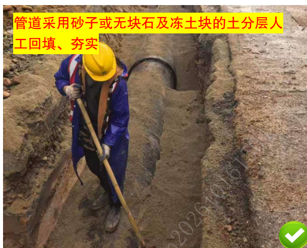
图 5.4.2-2 管道分层回填
