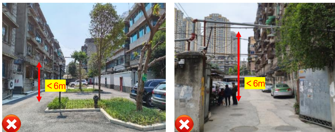
图 6.2.1 1KV 架空线距地距离应 \geq 6\text{m}
