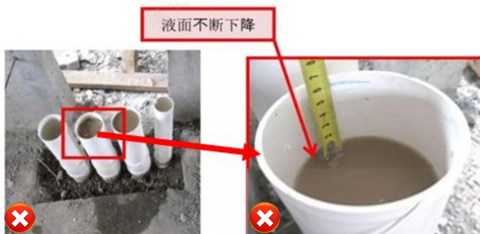
图 5.6.1-2 灌水试验液位下降
