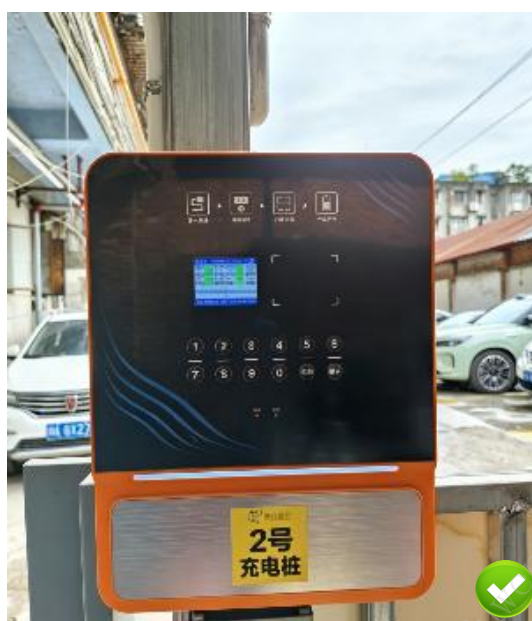
图 6.6.2-1 电动自行车充电桩
