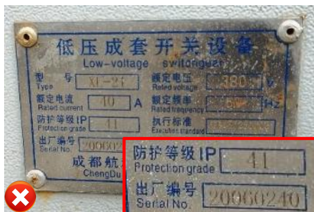
图 6.4.1-1 室外配电箱 IP 等级不符合要求
