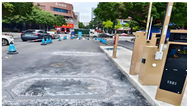
图 7.3.2-1 停车场感应线圈埋设
