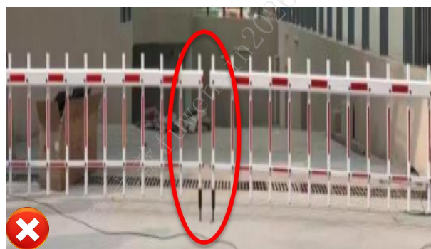
图 7.3.1-2 栅栏竖杆中间合拢缝太大
