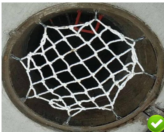
图 5.5.2-3 井盖明显标识、井盖上表面与路面相平 图 5.5.2-4 室外管井人孔设置安全平网
