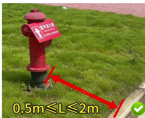
图 5.3.2-2 室外消火栓位置、高度符合规范要求
