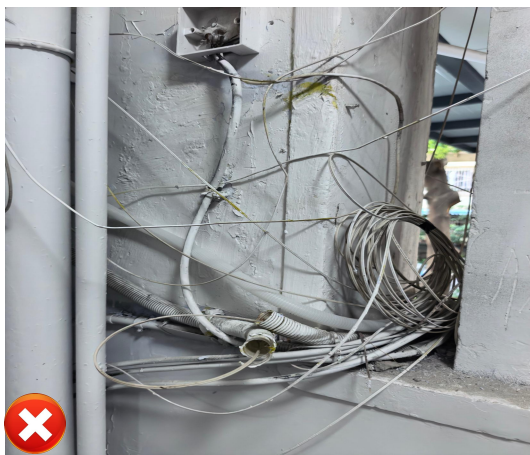
图 7.1.1-1 电线凌乱，线管脱落 图 7.1.1-2 箱体安装歪斜，无预制管口
