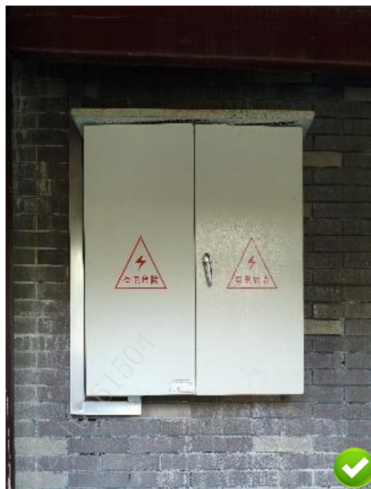
图 6.4.2-1 IP 等级满足设计要求 图 6.4.2-2 图形标志
