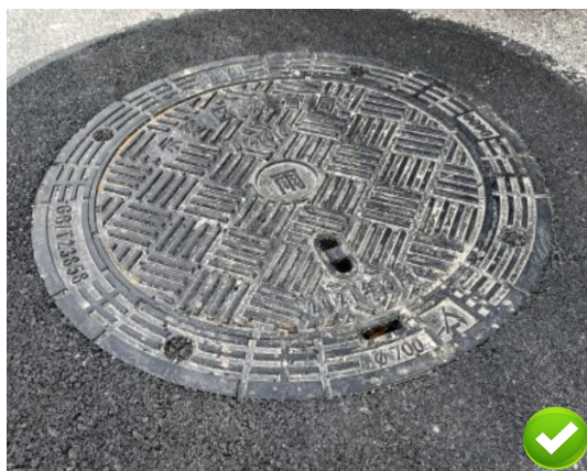
图 5.5.2-3 井盖明显标识、井盖上表面与路面相平 图 5.5.2-4 室外管井人孔设置安全平网
