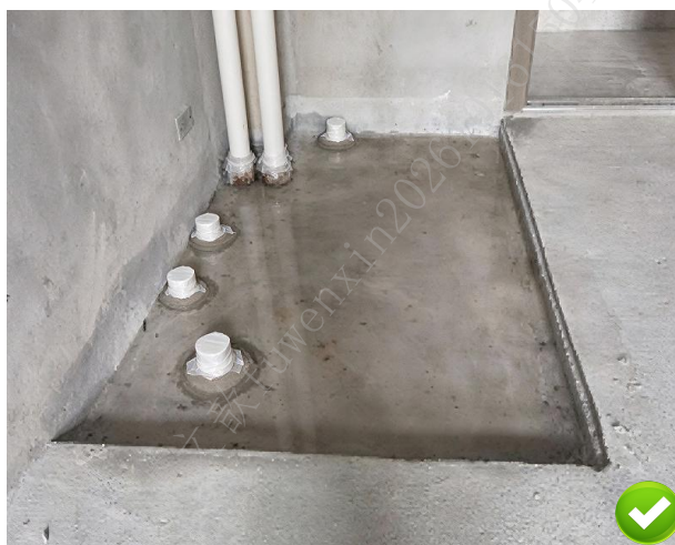
图 4.3.3 闭水试验现场影像
